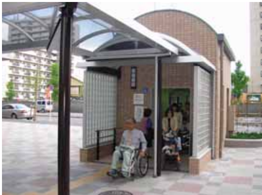
図 - 3 緑地公園駅構外エレベーター
