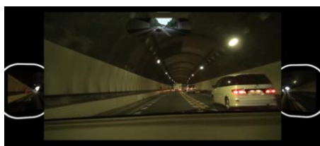
図10 映像の一例（田尻トンネル内） Fig. 10 Example of video (inside of Tashiri TN)
