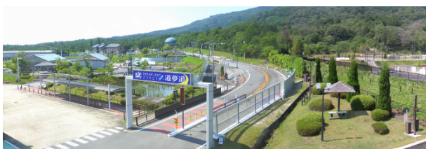
図 11 性能確認試験走路「道夢道」
