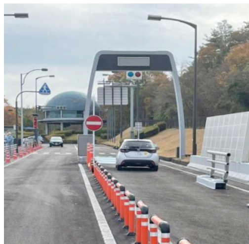
図 13 ETC ゲート逆走方向に進入禁止標識設置
