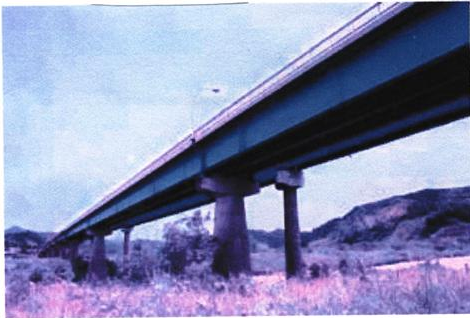
写真 現在の大雲橋，側道橋は本橋の陰になっている．細い橋脚と主桁下フランジが見える．本橋の主桁フランジより側道橋の主桁フランジが大きく，違和感がある．
